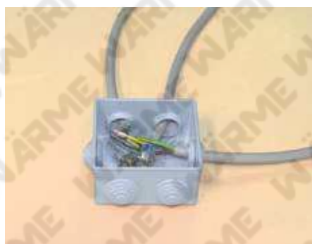
Cablare i cavi nella scatola di derivazione
