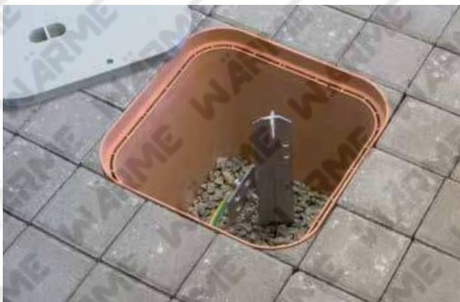
Installazione di un dispersore di terra Earthing rod installation
