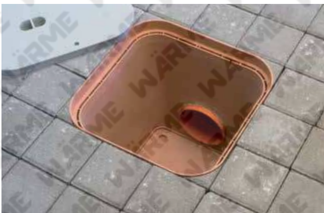
Installazione di un tubo per l'acqua Water pipe installation
